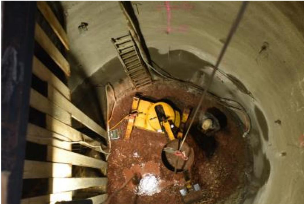
Blick in den Erkundungsschacht mit Minibagger und Kübel (Foto: DB AG)
